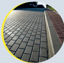
Мощение дорожек и тротуаров
