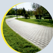
Прокладывание пешеходных зон
